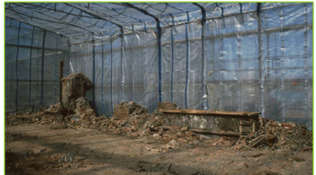
Altlastensanierung auf ehemaligem Fabrikgelände
